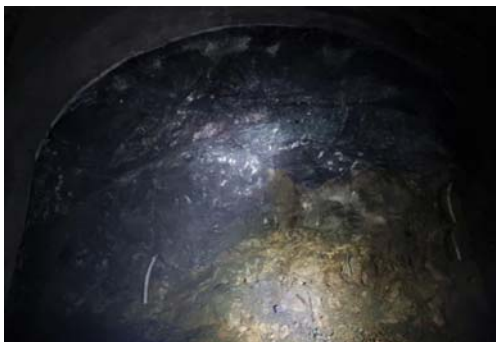
图8 堵水完整开挖后掌子面照片
