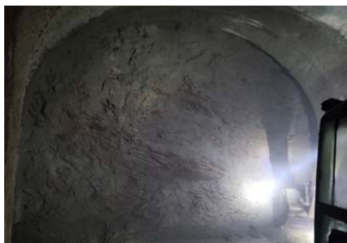
图12 桩号X2+145.5注浆完成 开挖后照片
