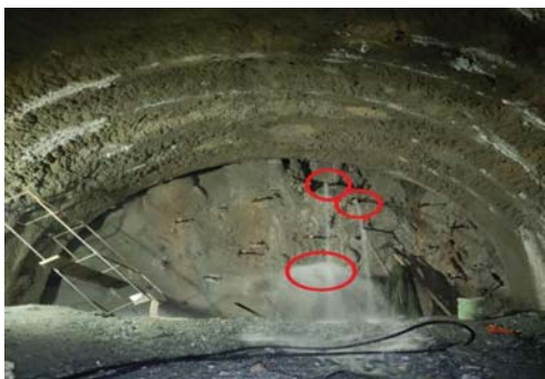
图9 X2+159.6掌子面 堵水前照片
