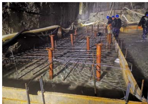
图18 第二次底板盖重混凝土及引水管施工前照片
