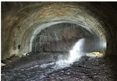
图11 X2+145.5掌子面 堵水前照片
