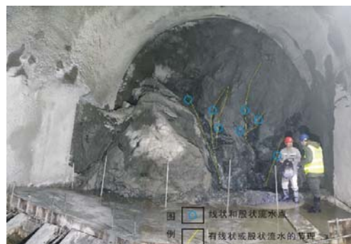
图5 止浆墙第一层浇筑完成后照片
