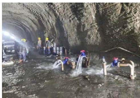
图17 第一次底板盖重混凝土及引水管施工前照片
