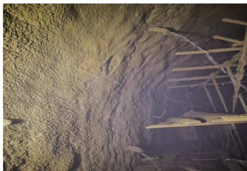
图14 系统径向灌浆照片
