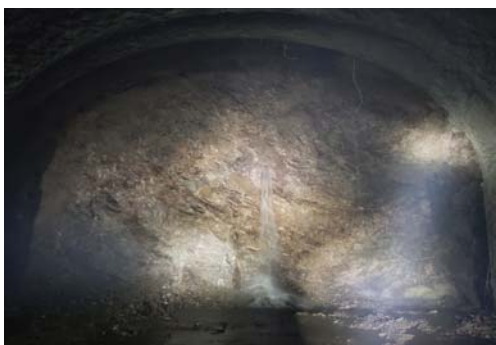
图10 桩号X2+159.6注浆完成 开挖后照片
