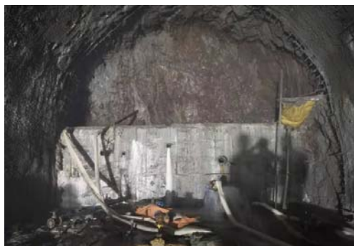
图15 掌子面止浆墙浇筑照片
