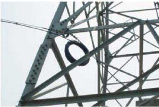
【案例2】雷电流沿架空光缆线路的钢绞线侵入通信基站
