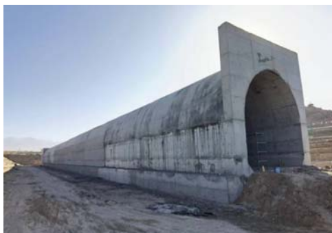
图1 放水廊道施工现场
