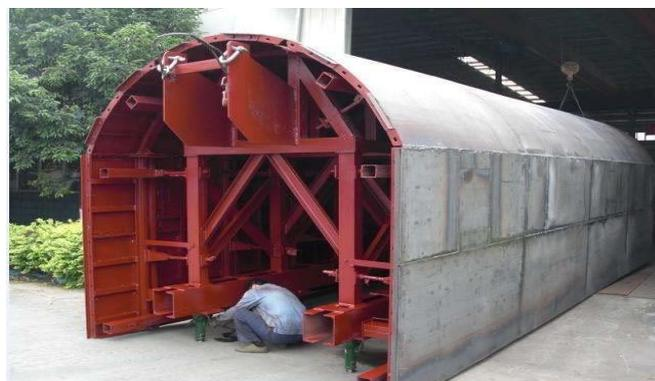
图2 大型模板尾水管搭建
