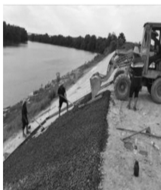
a 浇筑多孔混凝土
