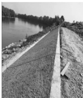
c 填充植被适应材料
