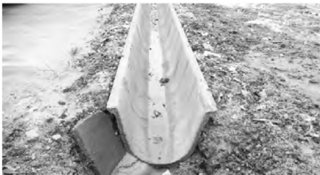
图1 水利工程U型槽
