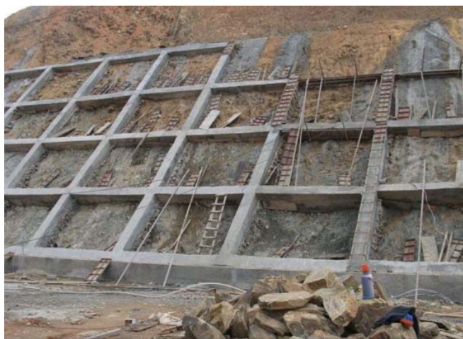
图一 水利工程边坡开挖支护施工前期
