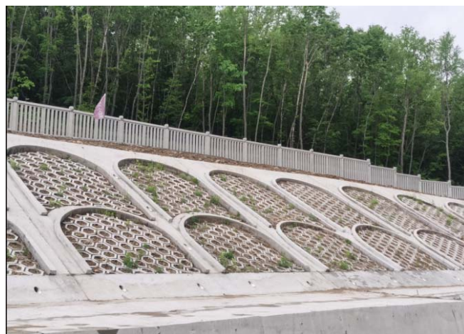
图二 水利工程边坡开挖支护施工完成图
