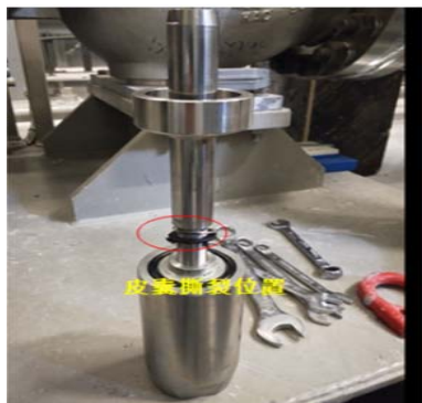
图2 ESV阀隔膜撕裂
