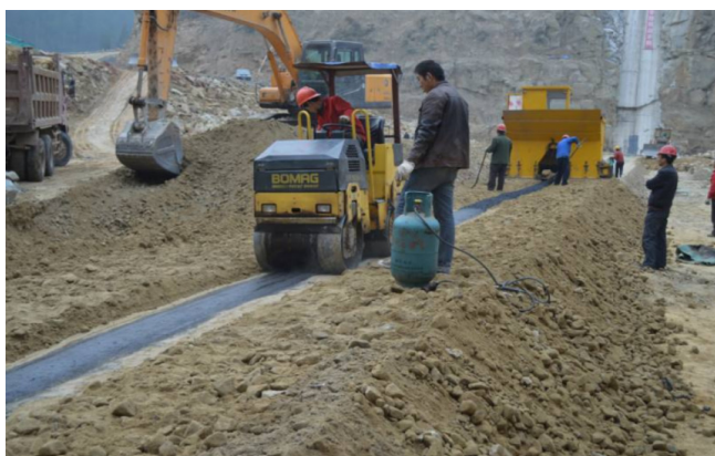
图1 碾压式沥青混凝土心墙施工
