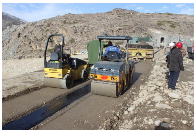
图2 沥青混凝土的摊铺与碾压
